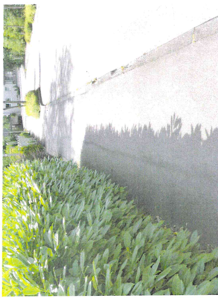
Bruchstellen an Bordsteinen
